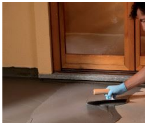
Impermeabilización de terraza con llana.
