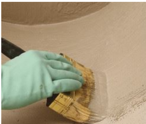
Impermeabilización de muro de cimentación con brocha
