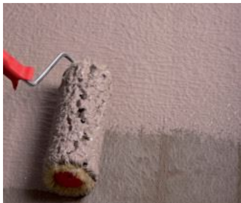
Impermeabilización de muro de cimentación con rodillo
