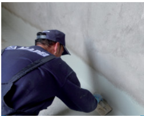
Mapelastic Foundation aplicado con llana, en una intervención de impermeabilización a contrapresión
