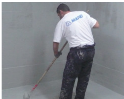
Mapelastic Foundation aplicado a rodillo, en una intervención de impermeabilización a contrapresión
